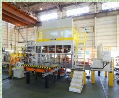
●設備の点検・調査
